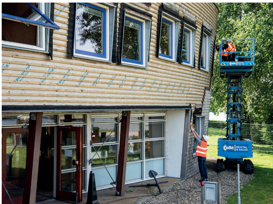
Foto 2: De buitenkozijnen, gevelbekleding, houten balken, maar ook de houten vloerdelen, binnendeuren en straatklinkers van het oude districtskantoor van RWS zijn gestript en worden hergebruikt in de nieuwe kliniek van Emergis.
