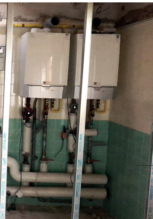
Foto 7 en 8: Uit de afgebroken vleugel komen (foto links) de cv-ketels die weer in de nieuwe technische ruimte geplaatst worden (foto rechts).
