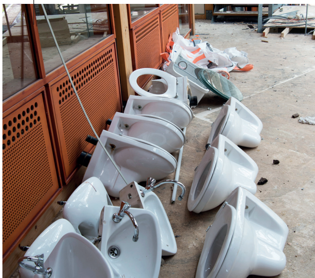
Foto 3: De wc-potten uit het oude gedeelte kunnen makkelijk opnieuw worden toegepast, maar dat geldt niet voor de inbouwreservoirs. Daarvoor zijn vanwege de levensduur nieuwe reservoirs gekomen.
